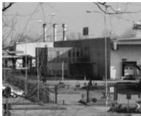
Una veduta dello stabilimento ex Polenghi Lombardo
